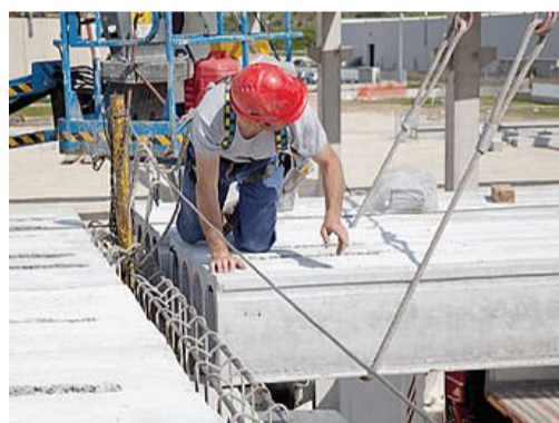
Speroni di ferro vengono infilati nella colonna per non farla muovere. A destra altri lavori antisismici
