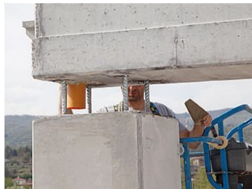
Speroni di ferro vengono infilati nella colonna per non farla muovere. A destra altri lavori antisismici
